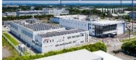
栃木テクニカルセンター(栃木)
